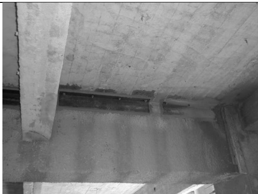
Σχήμα 6.11.: Αγκύρωση μανδύα σύνθετου υλικού για ενίσχυση πλακοδοκού.
